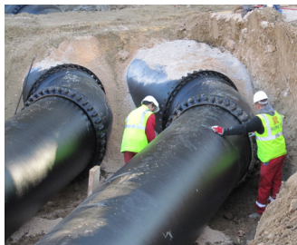
CU MARSEILLE – Ste Marthe (13) AEP – FONTE 2 X Ø 1200
