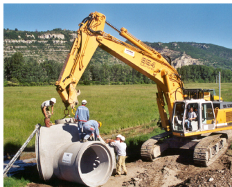
SDEA BETON Ø 2 200 EP - LE POUZIN (07)
